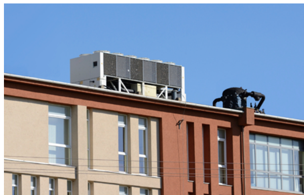
Tradycyjna instalacja na dachu.
