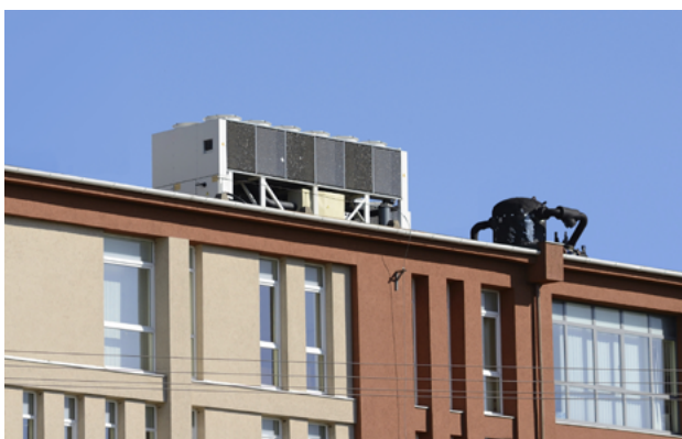
Tradycyjna instalacja na dachu.
