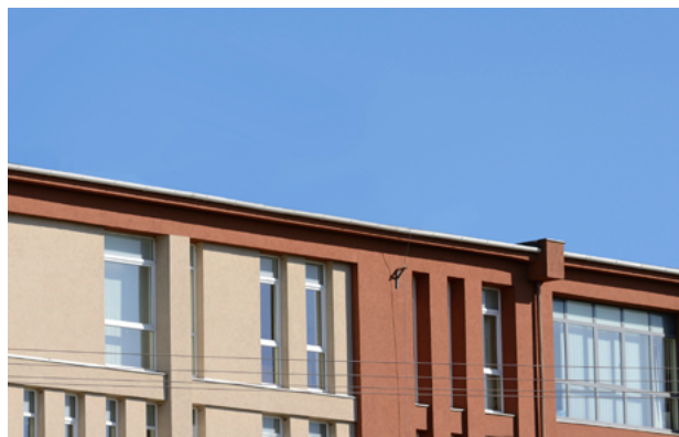
Agregat chłodniczy zintegrowany z centralą klimatyzacyjną oznacza brak szpecących instalacji na dachu.
